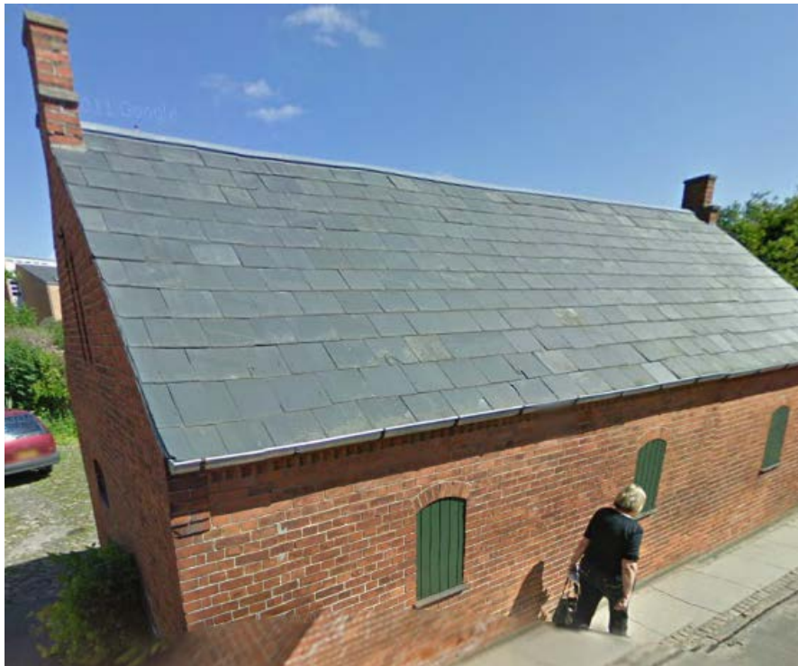
Figur 2 Tropslokale nummer to på Sofiendalsvej 1, Haslev
